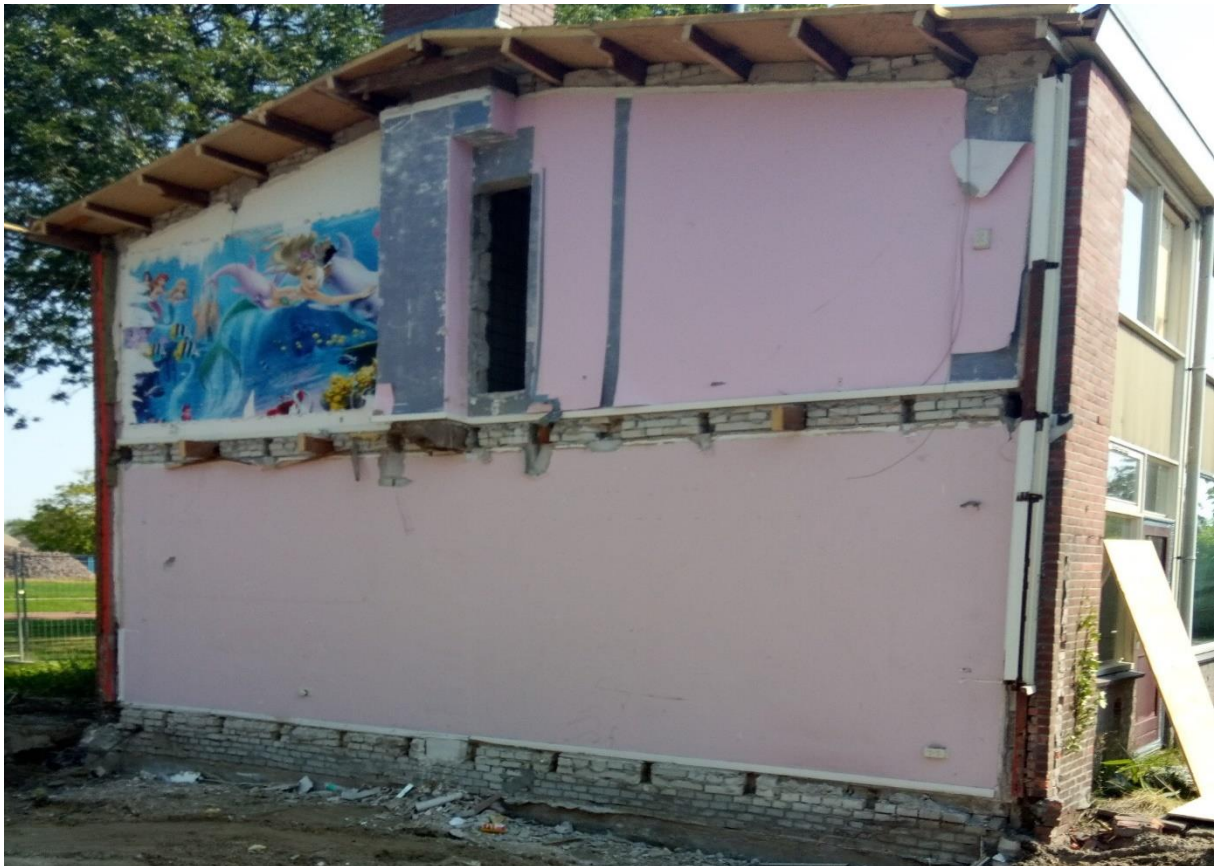
Sloop woning Halbertsmastraat te Buitenpost
